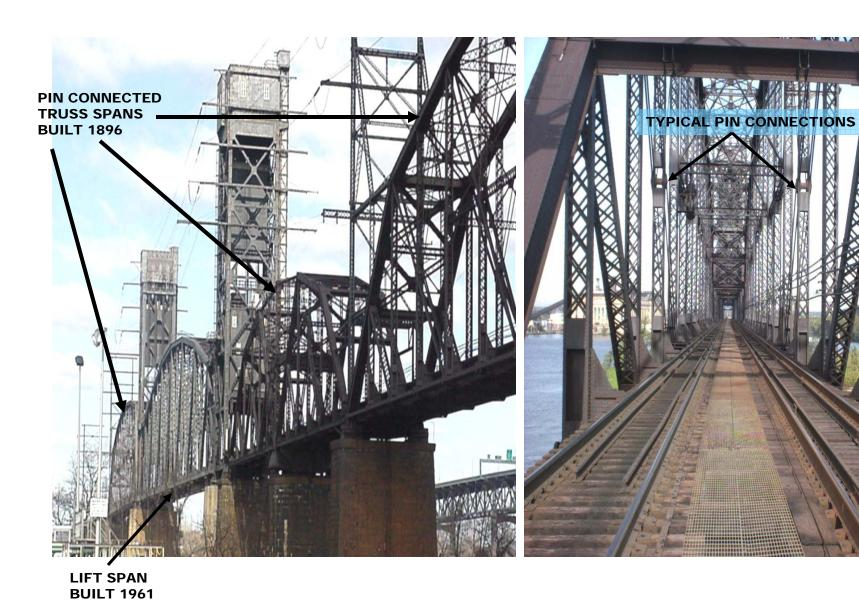
DELAIR MOVABLE BRIDGE TRUSS SPANS
